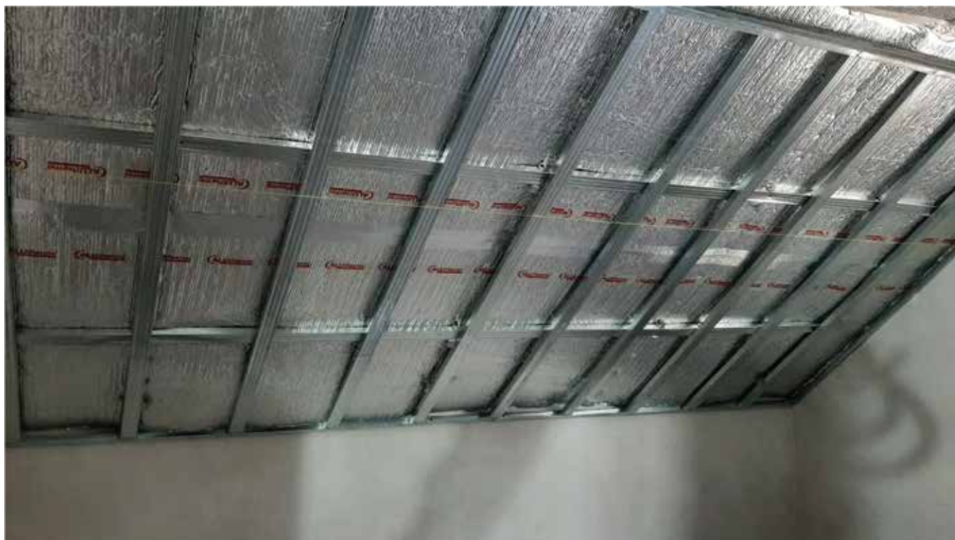
Przykładowa realizacja w systemie podkrokwowym
